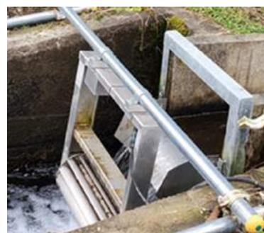
図2 水車装置設置状況
